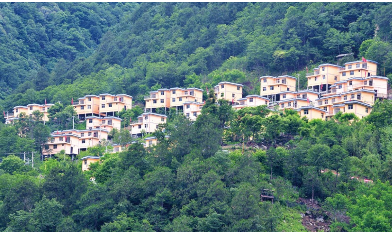
▲ 怒江易地扶贫搬迁安置点
