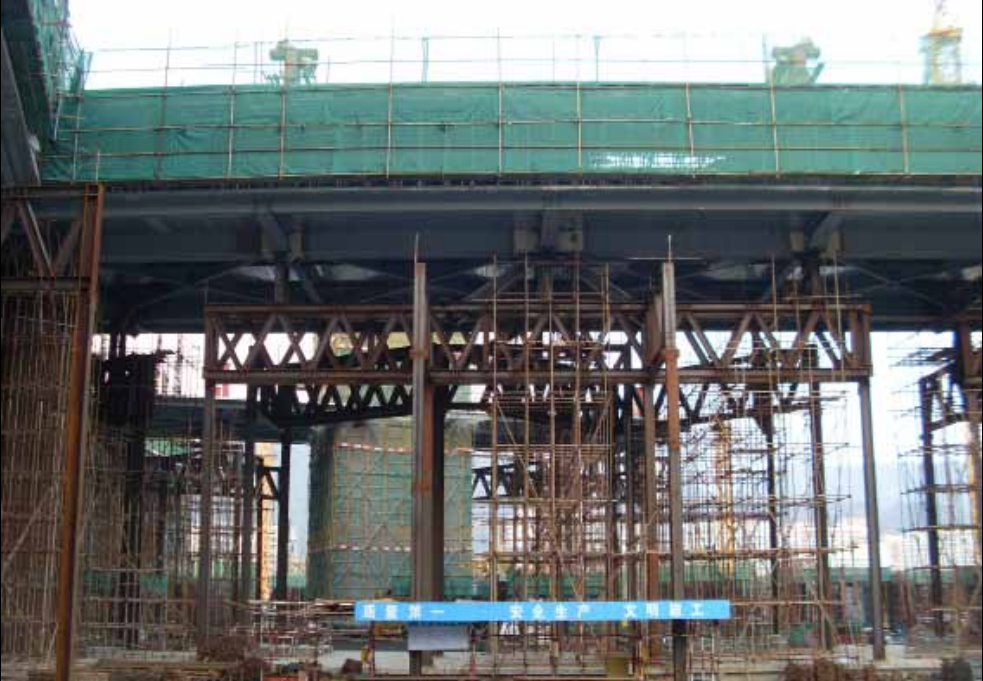
2008年3月, 上部结构临时支撑。 March 2008, temporary support of upper structure.
